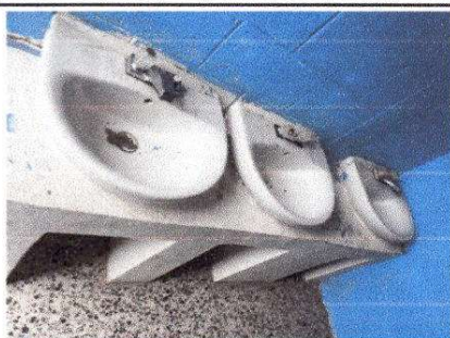
FOTO 1: Sustrucción de mezcladora lavamanos (contra llave, tubo de abasto)
