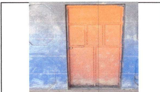
FOTO 10: Fabricación e instalación de puertas de metal en módulos
