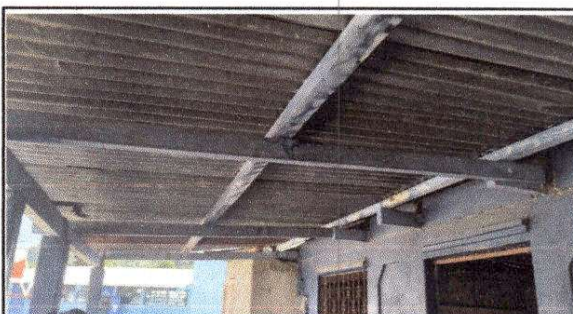
FOTO 4: Sustrucción de estructura de soporte de madera, por metal
