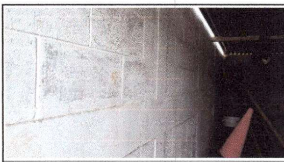
FOTO 12: Repello en muro
