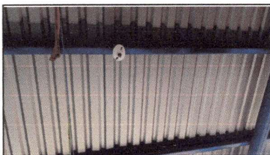
FOTO 9: Sustrucción de focos ahorradores
