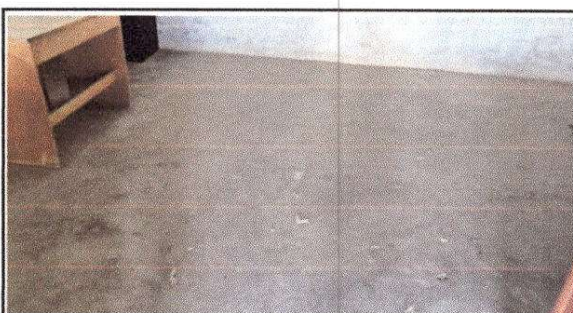
FOTO 6: Sustrucción de piso liso por piso cerámico
