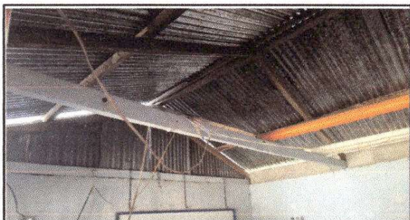
FOTO 3: Sustrucción de lámina, por lámina troquelada aluzinc calibre 26, Sustrucción de capote de lámina para lámina troquelada Y Sustrucción de elementos de fijación
