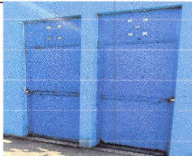
FOTO 2: Fabricación e instalación de puertas de metal en módulos
